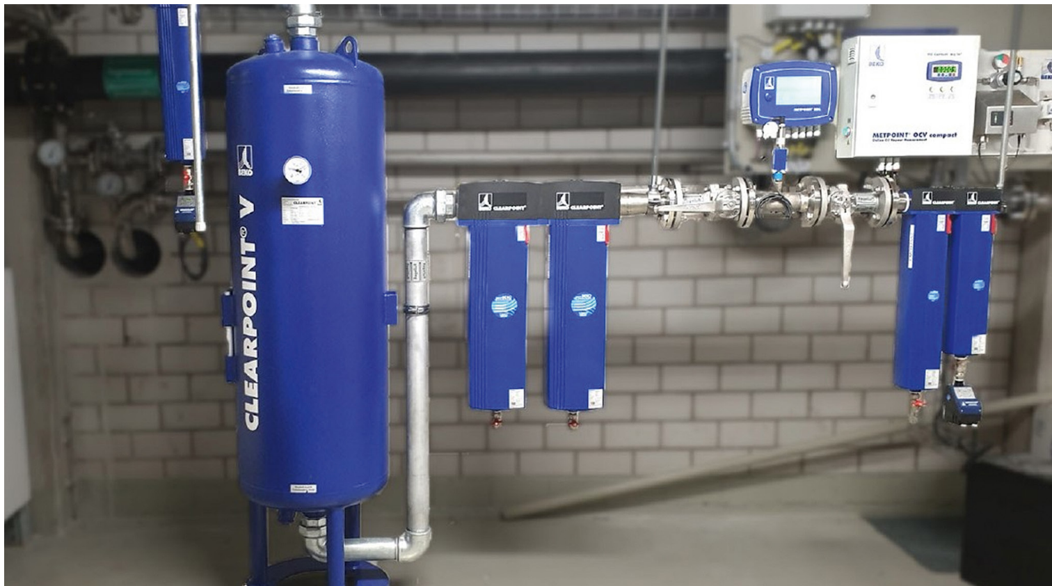
Ligne de filtration de l'air comprimé Beko Technologies.
