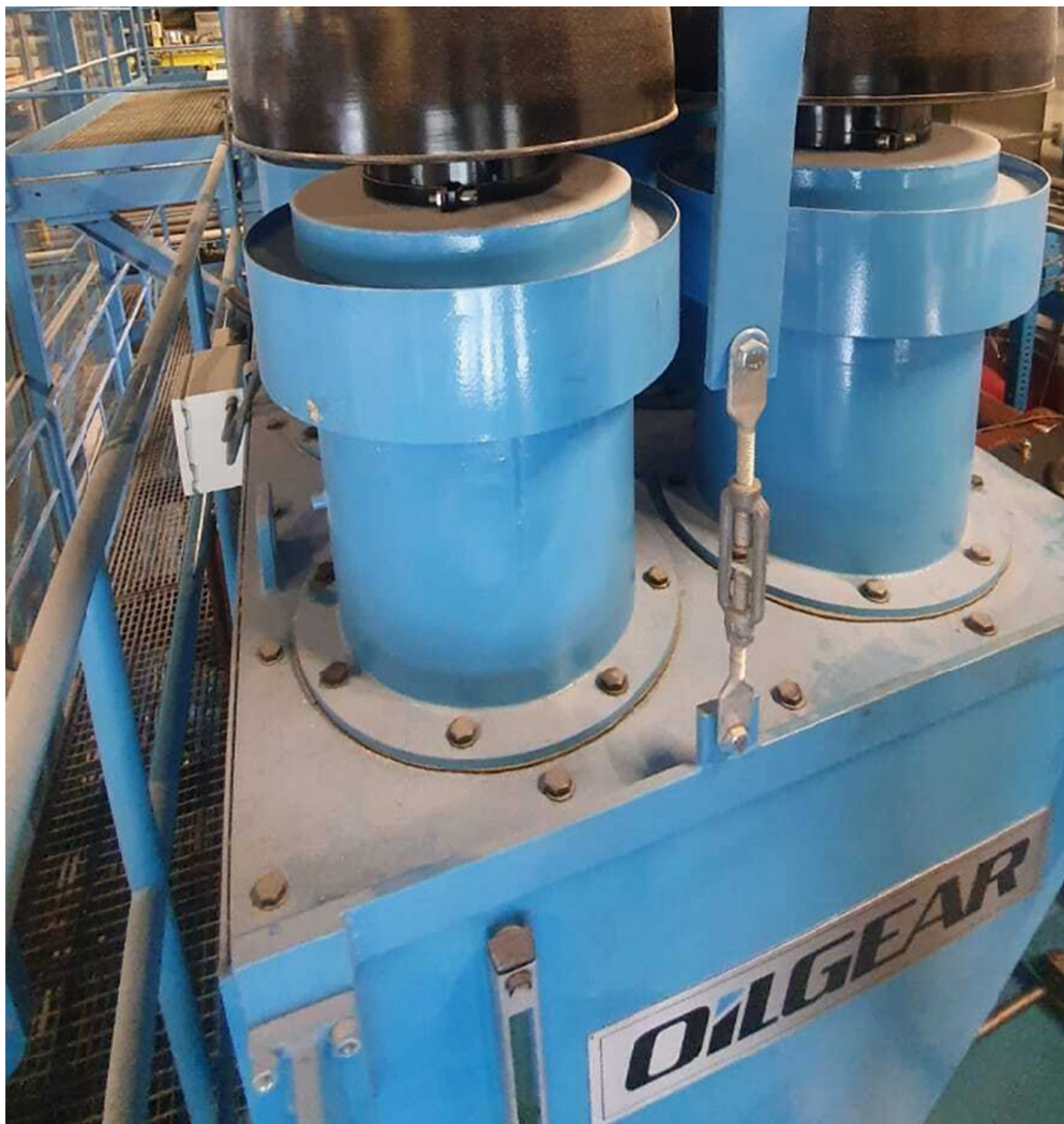
La gamme Air Dry Filter d'Oilgear est destinée à la purification de l'air entrant et sortant des réservoirs de grosse capacité.
