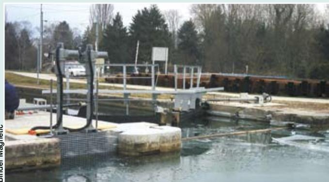
L'équipement complet de l'écluse de Brunstatt comprend 4 commandes de portes 20 kN / 1200 mm, 3 commandes de vannes registre 55 kN / 430 mm et 2 commandes de vannes de contournement 55 kN / 1 230 mm.
