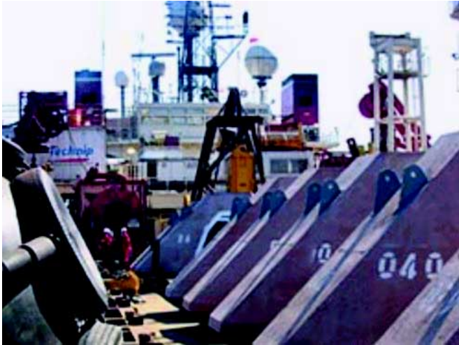
Alignement de pièces d'ancrages en attente d'être soulevées du pont par le système hydraulique Enerpac. Le système des valves de sécurité et de commande pour dito
