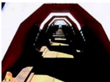
Les châssis mobiles sont alignés avant le déroulement de la chaîne des pièces d'ancrage, laquelle pèse 28.800 tonnes et est destinée à la grande conduite de 42 pouces
