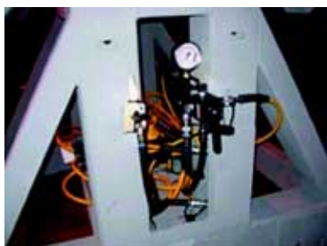
Sécurité était le mot d'ordre pour tous les équipements hydrauliques, avec en plus la nécessité d'un contrôle précis de chacun des vérins groupés par quatre pièces, et la capacité d'assurer l'arrêt de sécurité.
