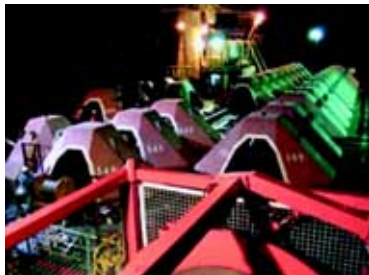
Le système hydraulique Enerpac a été construit sur mesure pour soulever et positionner cette chaîne de pièces d'ancrage de 32 tonnes, destinées à fixer un oléoduc sous-marin long de 80 km
