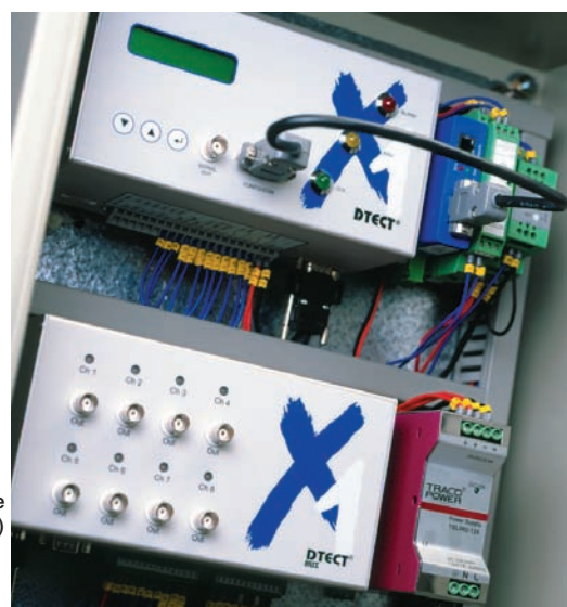
Appareil de surveillance vibratoire (à droite)
