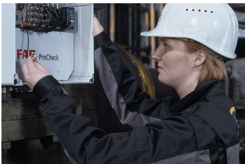
Système de surveillance en ligne (à gauche)
