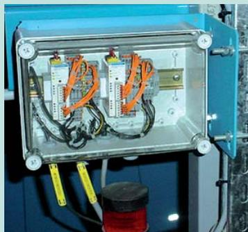
Une cellule transmet l'information de présence d'un bagage au boîtier AS-i qui commande l'aiguillage.
