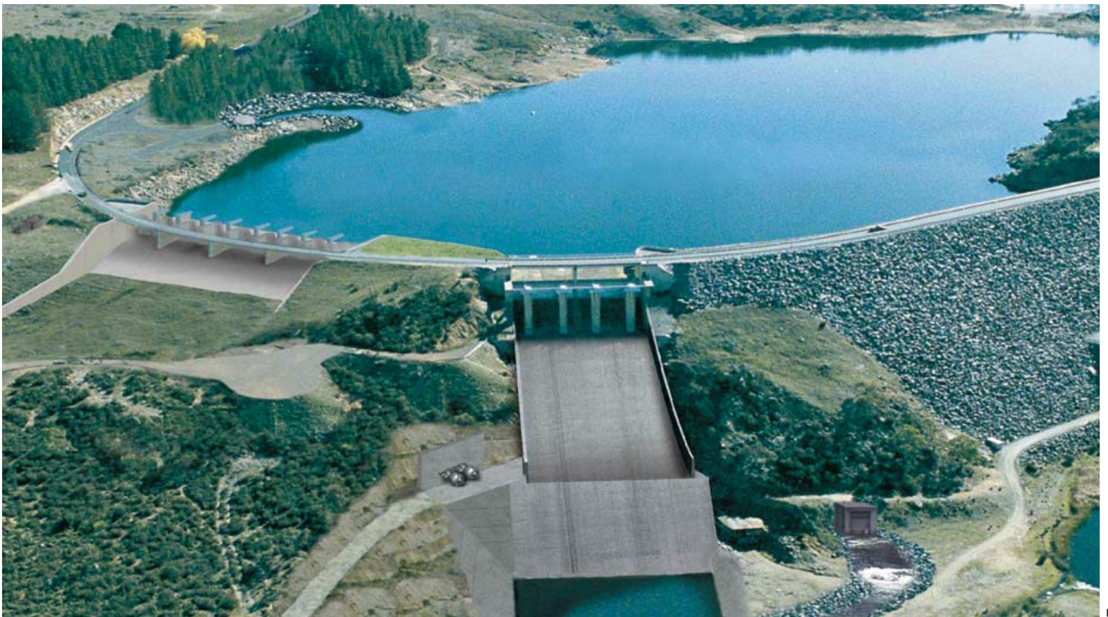
Vue des hausses fusibles
