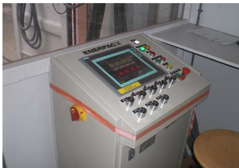
Commande PLC centralisée du système de levage hydraulique synchronisé à quatre points.
