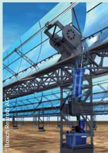
Système hydraulique servant à l'orientation de panneaux photovoltaïques.
