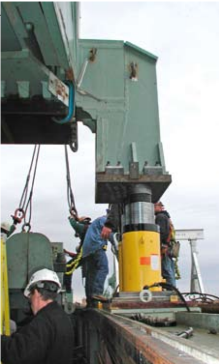
Retrait de l'un des bogies d'origine. Deux vérins soulèvent les éléments de fixation utilisés pour la dépose. Même chose pour les deux autres vérins, de l'autre côté du rail.
