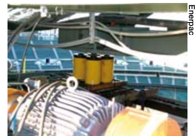
Levage avec agencement des vérins par groupe de quatre. Vérins équipés d'un couvercle rond en plomb et reposant sur un "sandwich" en Téfalon pour autoriser un déplacement latéral.
