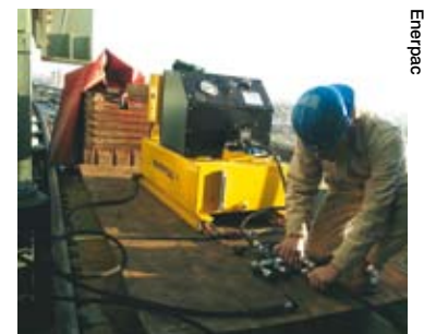
Raccordements au niveau du manifold hydraulique, avec la pompe électrique de 12,5 HP en arrière plan.
