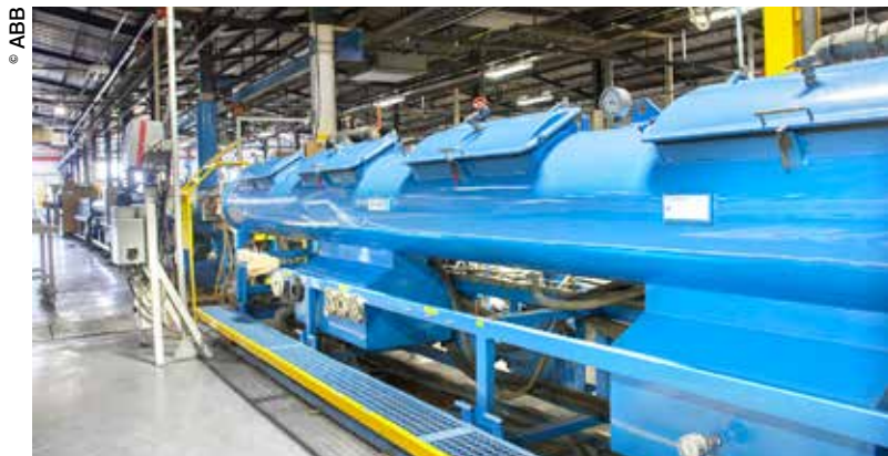
Chez Radius Systems, les moteurs CC traditionnels alimentant les chaînes d'extrusion sont progressivement remplacés par des moteurs CA dans le but d'optimiser la consommation d'énergie, d'abaisser les coûts de maintenance et de réduire le bruit.
