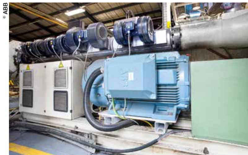
Le moteur SynRM IE4 de 200 kW s'installe parfaitement dans l'espace laissé vacant par le moteur CC dans l'extrudeuse.
