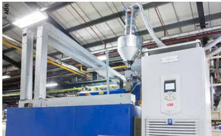
Le pack moteur-variateur SynRM s'est avéré efficace pour les applications à couple constant de la chaîne d'extrusion chez Radius Systems, tout comme il l'est pour les applications à couple quadratique dans les pompes et les ventilateurs.
