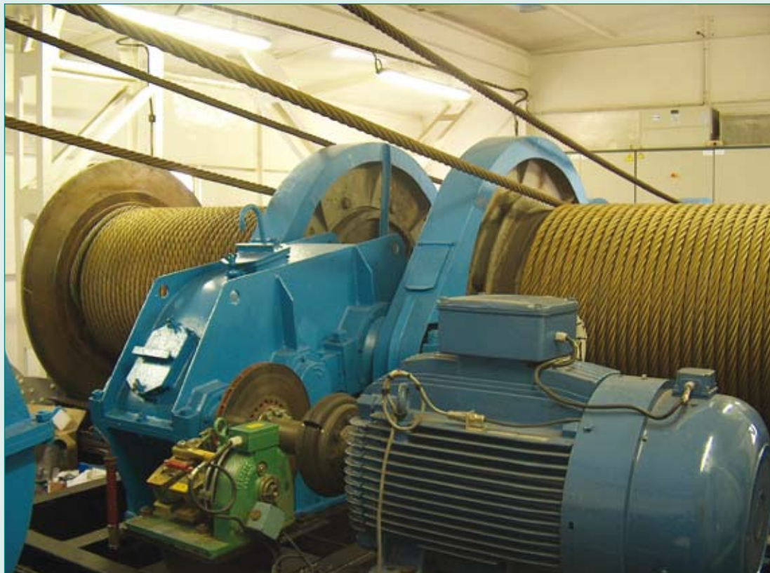
Une application de la solution Altium : Rénovation et optimisation de l'exploitation d'une grue de réparation navale alimentée par l'intermédiaire d'un enrouleur Delachaux 400V au Port Autonome de Marseille
