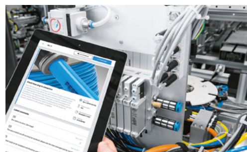
Smartenance rend obsolète la maintenance préventive chronophage des systèmes.
