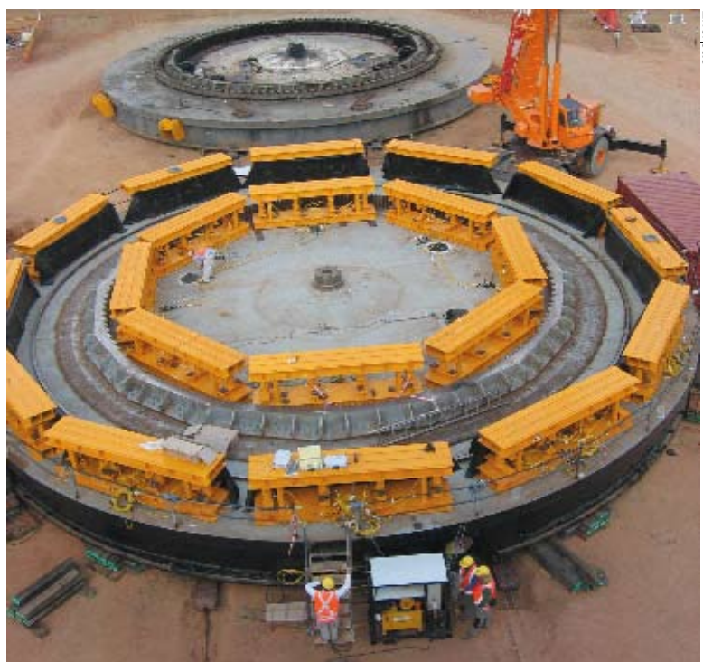
Le système de levage hydraulique synchronisé Enerpac a été utilisé par G & S Engineering Service pour lever, avec une tolérance de 0,5 mm, l'énorme excavatrice dragline de 3500 tonnes d'une exploitation minière en Australie.
