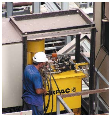
Six groupes hydrauliques se sont chargés de l'alimentation en pression 700 bars du système ayant permis la construction des nouvelles jetées du port de Carthagène, en Espagne.
