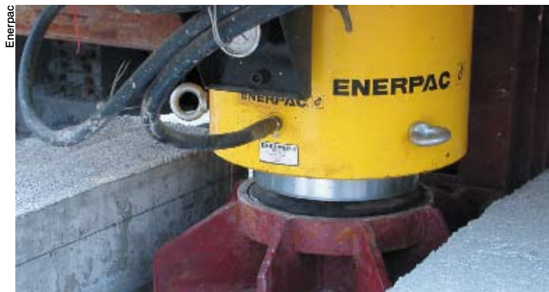
Le système hydraulique intégré d'Enerpac a permis de déplacer le Shanghai Concert Hall, une construction vieille de 74 ans !
