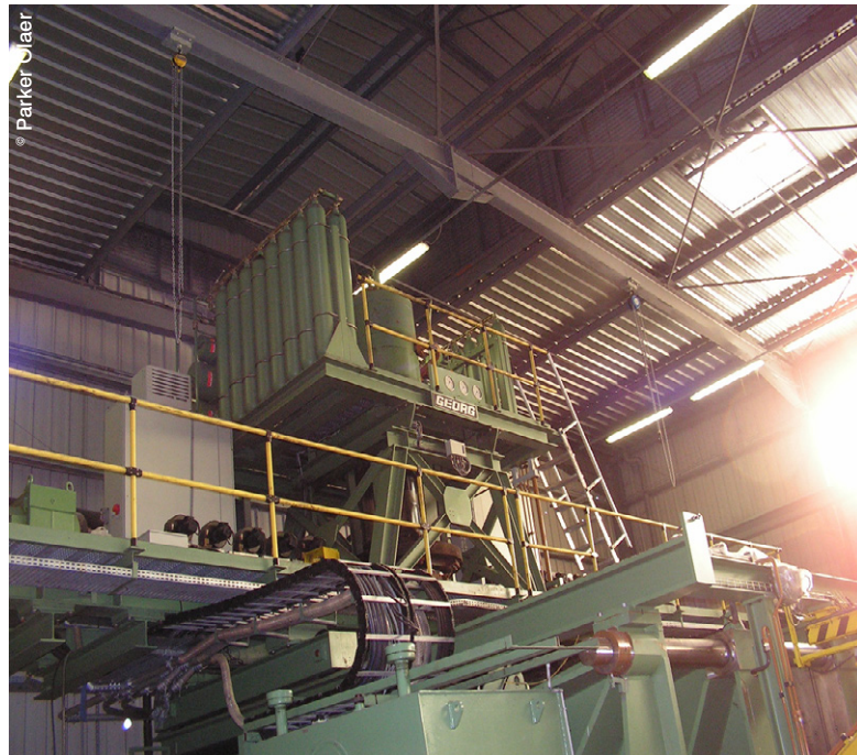
Accumulateurs à pistons + bouteilles additionnelles sur une presse à injection plastique.
