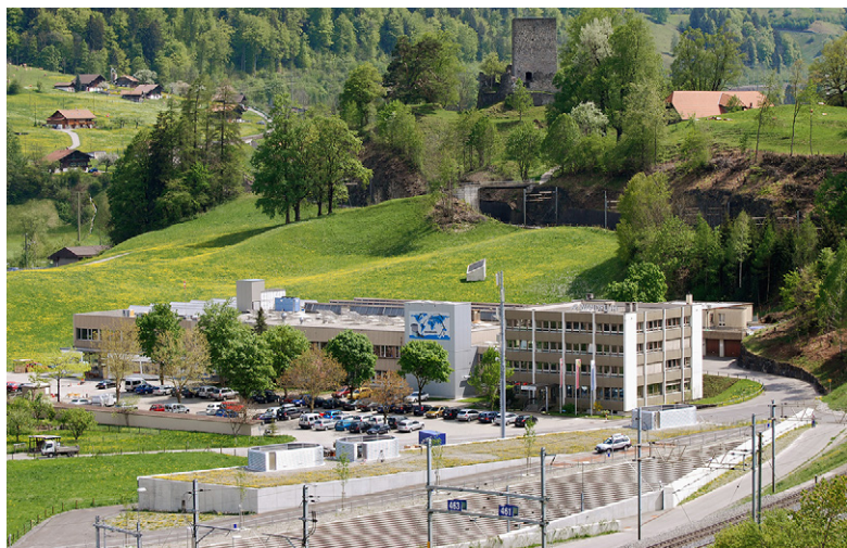
Quelque 8 millions d'euros vont être consacrés au projet d'extension de 50% de la superficie de l'usine de Frutigen. Le lancement des travaux est prévu dès le printemps 2016.
