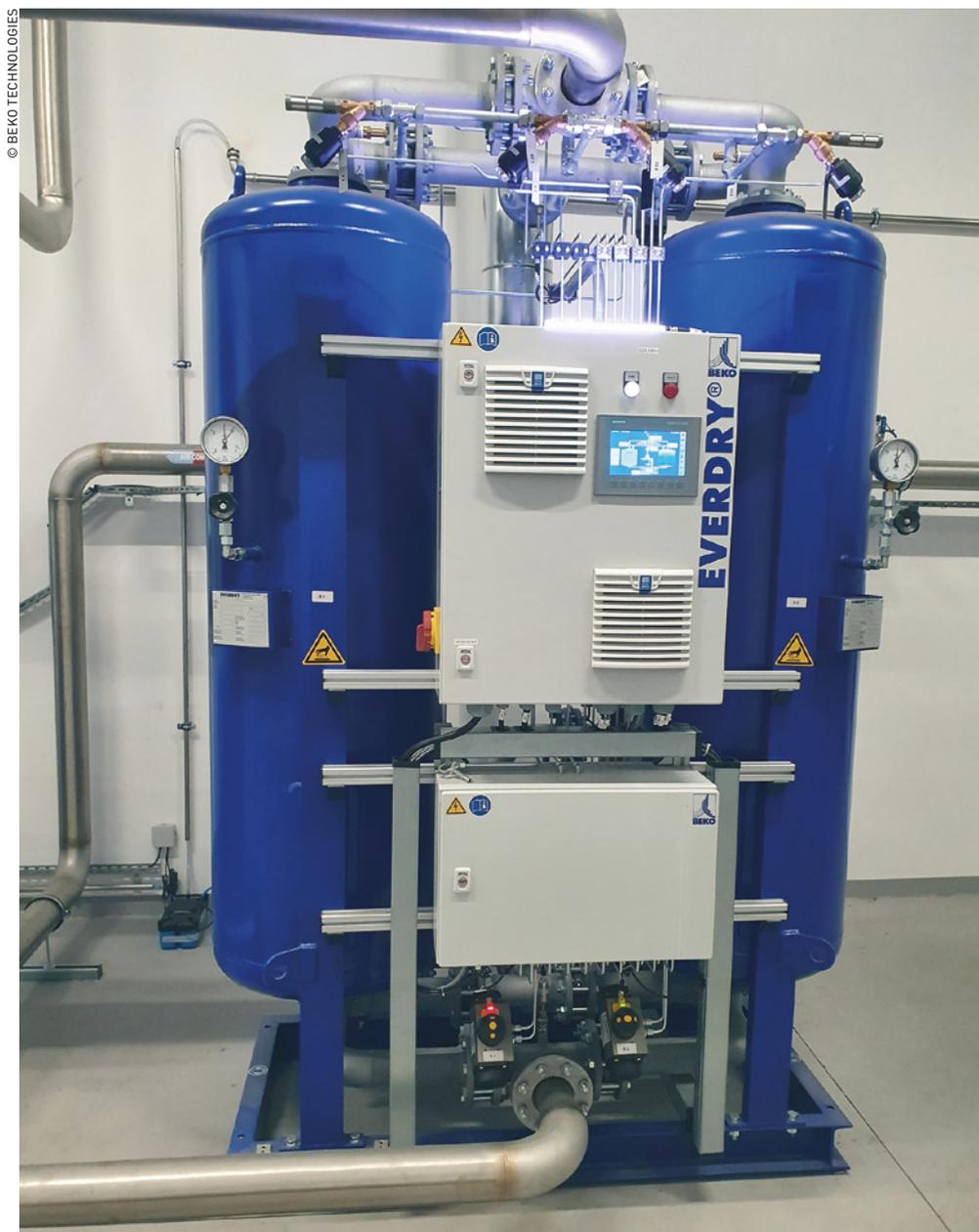
Sécheur par adsorption à chauffe externe « zéro purge » Everdry.
