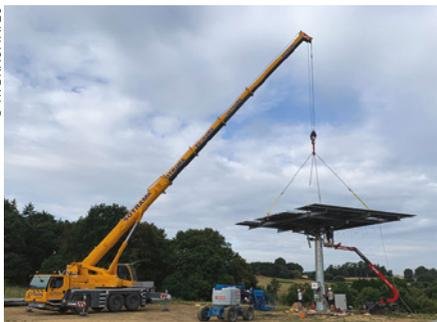
la PME, vient d'investir dans 140 m<sup>2</sup> de panneaux solaires pourvus de trackers, qui orientent les panneaux en fonction de la position du soleil, pour
