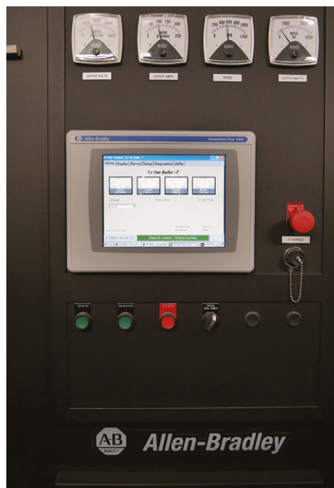
Terminal graphique PanelView, permettant de surveiller en temps réel la consommation énergétique.
