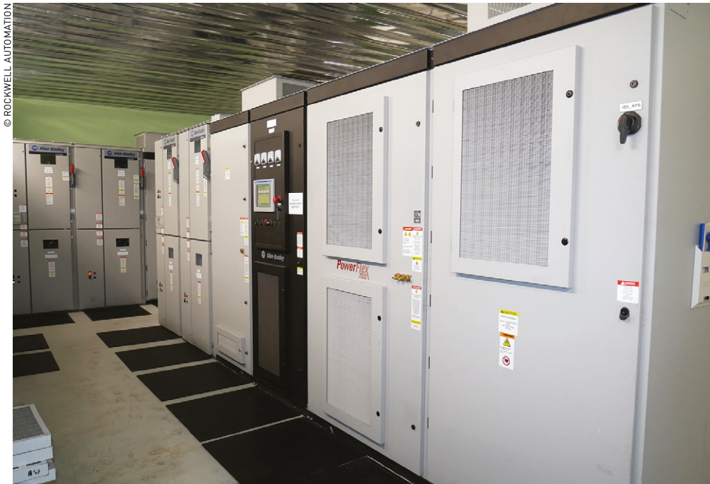
Variateurs de vitesse Allen-Bradley PowerFlex 7000, installés dans l'usine bulgare de Solvay.
