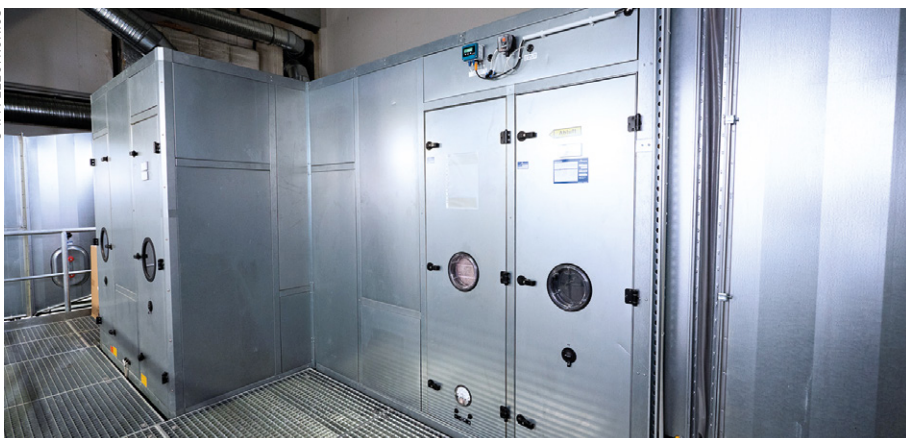
Le protocole IO-Link, en équipant l'essentiel des composants proposés par ifm permet notamment de procéder au bon moment au changement des filtres via la plateforme de maintenance Smart Observer.
