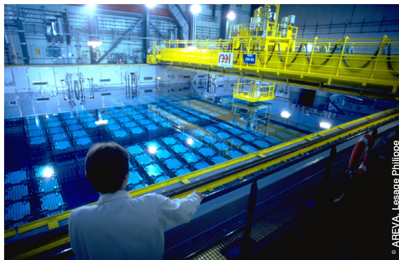
Piscine d'entreposage des combustibles usés. Usine de traitement des combustibles usés AREVA, établissement de La Hague. Cherbourg. France
