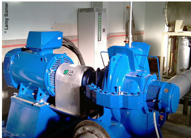
Leroy-Somer a remplacé les deux moteurs par un unique moteur synchrone à aimants permanents PLSRPM 315 de puissance 350 kW avec une vitesse de rotation de 1500 tours/min, commandé par un variateur Powerdrive MDS 470T pour gérer au mieux les régimes variables
