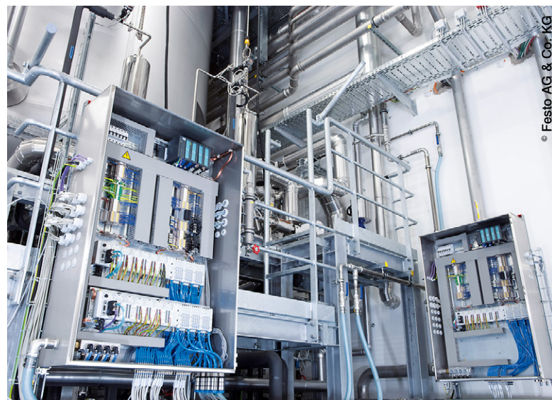
Les armoires de commandes modulaires facilitent la maintenance et le diagnostic de l'usine de solutions pour perfusions de B. Braun Melsungen.
