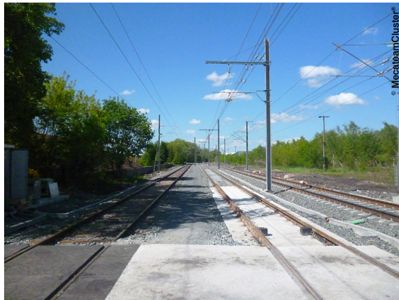
Trois « voies écoles » ont été inaugurées au sein de la zone des Chavannes. Dotées de passages à niveau, aiguillages, signalisations et armements caténaires, ces voies constituent une véritable reconstitution du réseau ferroviaire.
