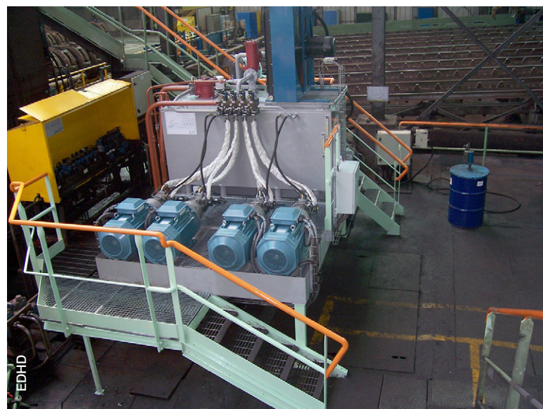
Centrale hydraulique de 2.200 litres avec 4 GEP de 30 kW (145 l/min)
