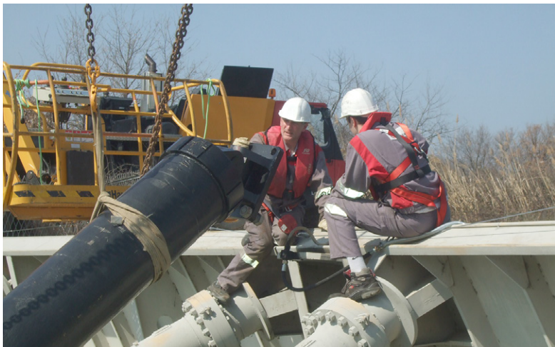
Réparation de vérins hydrauliques sur site.
