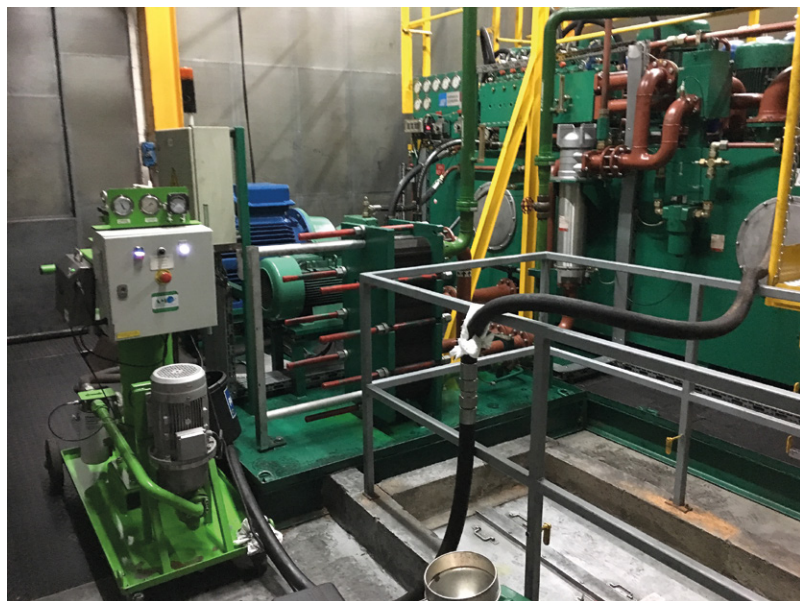
Dépollution d'une charge de 5m 3 dans une centrale hydraulique de laminoir, après un test MPC (vernis et précurseur de vernis) trop élevé. Passage de 33 à 10 après 2 mois de traitement avec filtre 0,9µ.
