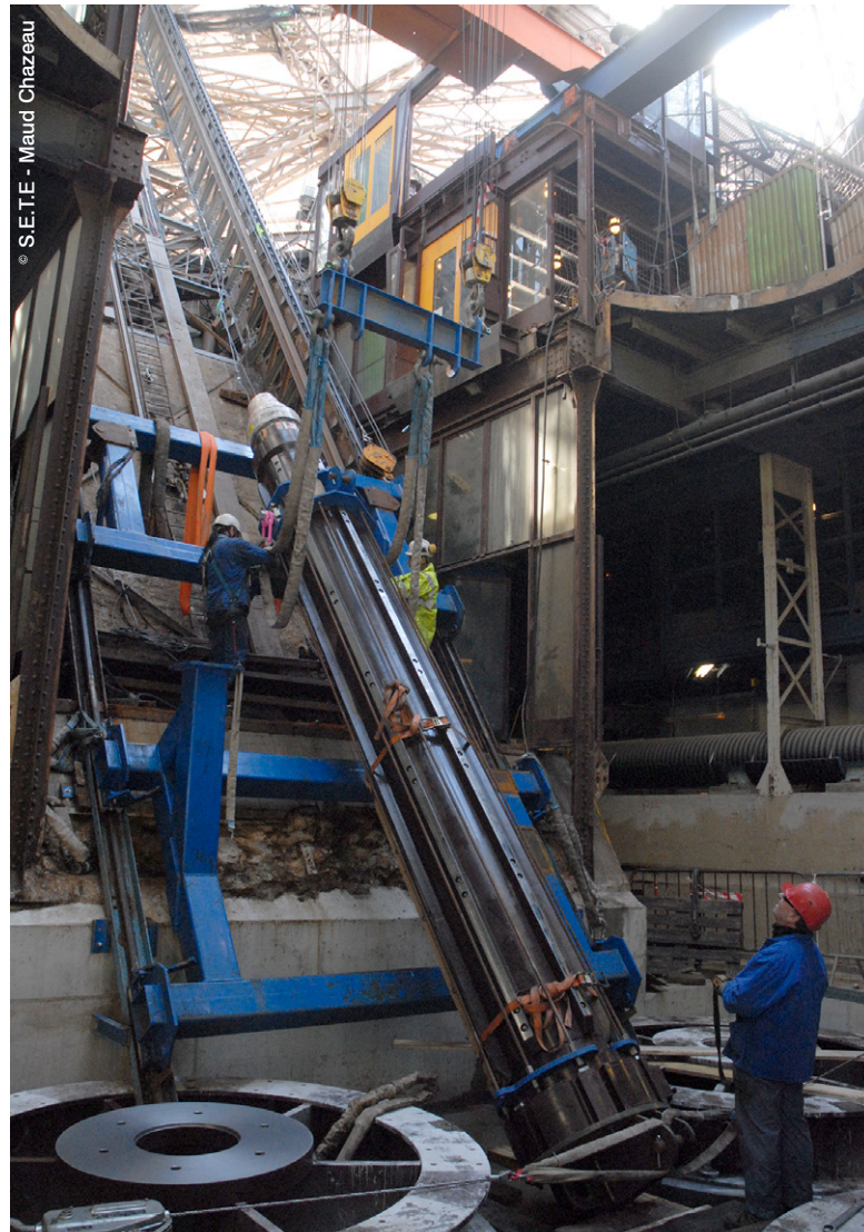
Le projet "Tour Eiffel", un challenge d'envergure pour Bosch Rexroth : conserver le principe de l'ascenseur d'origine, imaginé par Gustave Eiffel, tout en intégrant les contraintes de sécurité et de confort actuelles et les dernières technologies en matière d'économie d'énergie.
