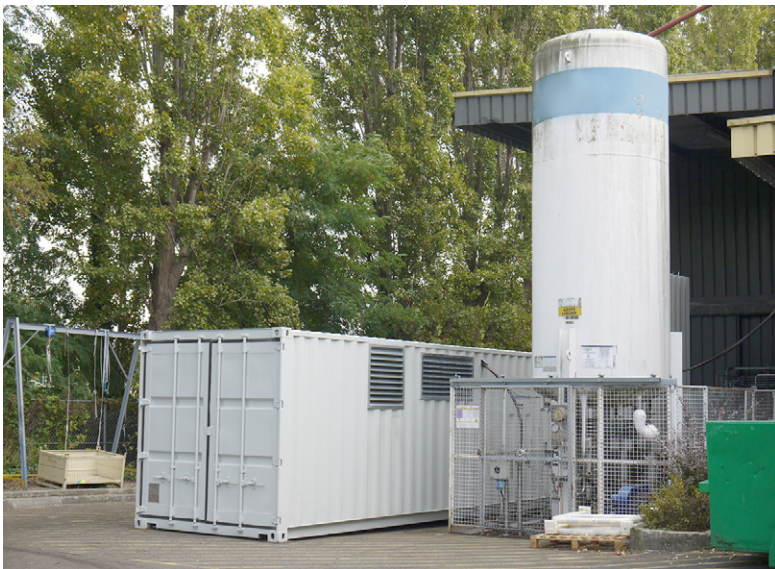
À gauche, le container dans lequel sont installés les équipements Parker servant à la production d'azote.
