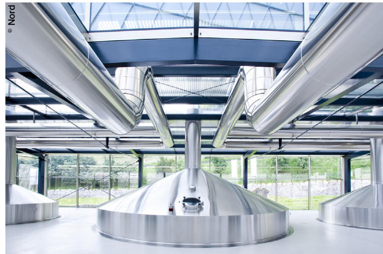
D'un diamètre de 8,6 mètres, la cuve de clarification constitue le cœur de la salle de brassage. Ici, le moût est automatiquement séparé des drêches.
