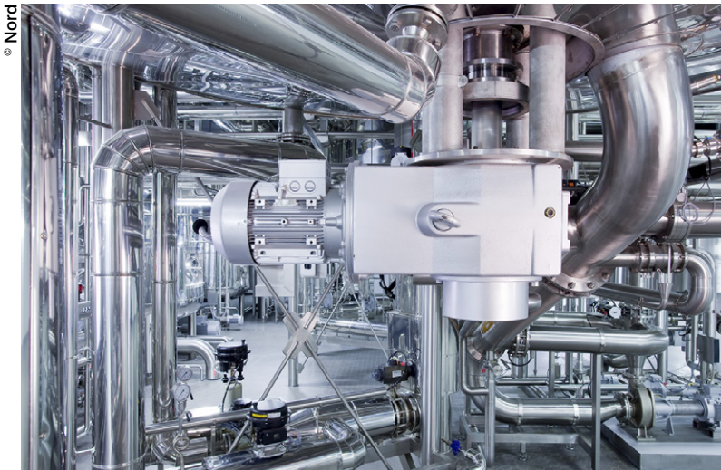
Chaque système d'entraînement a été adapté aux besoins spécifiques de l'application. Ici, un motoréducteur à couple conique alimentant la cuve de clarification.
