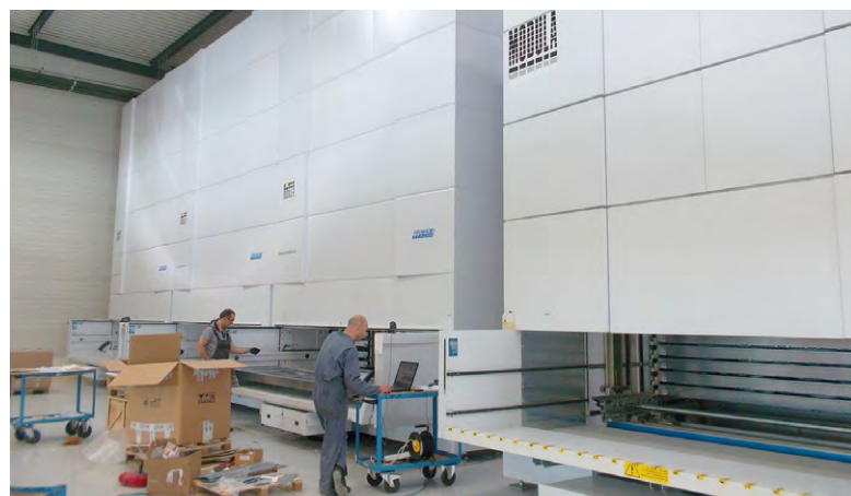
L'entreprise a mis à profit l'emménagement au sein des locaux de Mennecy pour équiper ses stocks de quatre nouveaux magasins verticaux automatiques.
