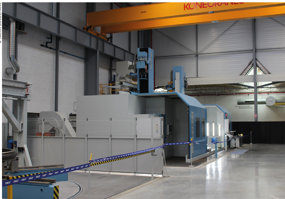
Le bâtiment a été rehaussé de plusieurs mètres pour pouvoir accueillir les machines-outils qui usineront ces pièces d'exception.
