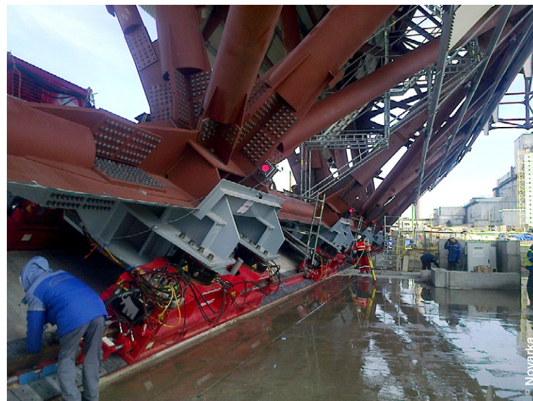
L'arche a été construite en deux parties (moitiés), réunies fin 2014 par glissement de l'une vers l'autre. Une fois assemblée, elle sera équipée de ponts roulants (2 x 750 tonnes) destinés au démantèlement du sarcophage et du réacteur accidenté.
