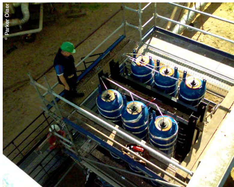
Accumulateurs de 575 litres utilisés en réserve d'énergie sur une installation de fuel à haute température.
