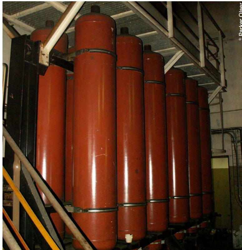
Batterie de douze accumulateurs à vessie de 200 litres.
