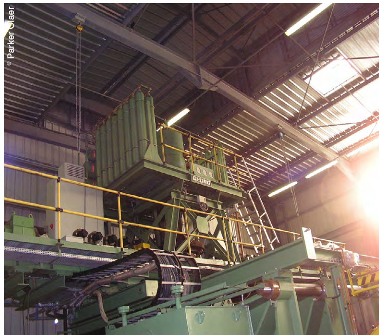
Accumulateurs à pistons + bouteilles additionnelles sur une presse à injection plastique.
