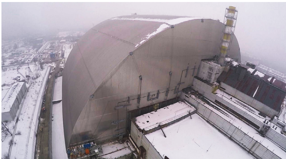
52 vérins autonomes ont été utilisés pour la mise en place de la nouvelle enceinte de confinement de la centrale nucléaire de Tchernobyl.
