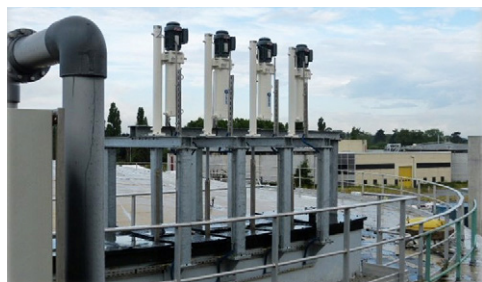
Auto-vérins ATEX installés sur un site de production de Biogaz.
