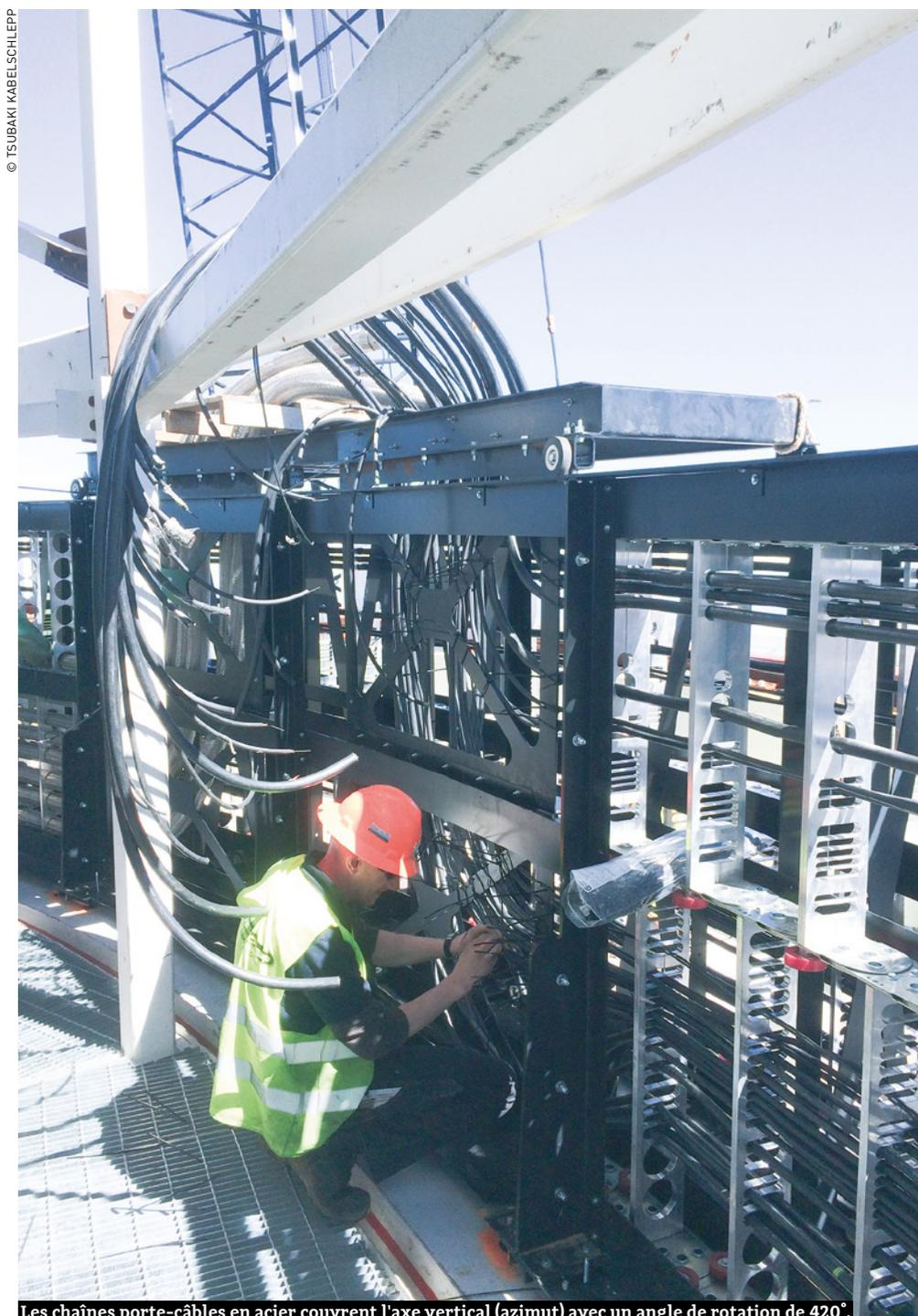
Les chaînes porte-câbles en acier couvrent l'axe vertical (azimut) avec un angle de rotation de 420°.
