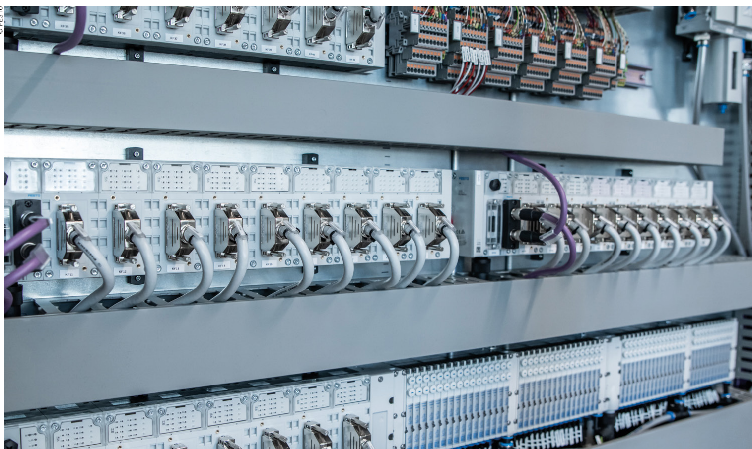
Optimisation de l'espace, du câblage et de l'étiquetage des composants dans l'armoire de commande pour un grand nom français de l'industrie pharmaceutique.
