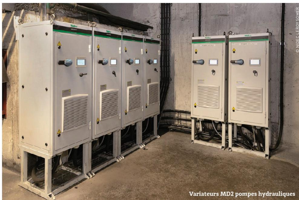
énergétique et de variateurs de vitesse compacts prêts à l'emploi Powerdrive MD2. L'objectif à terme est d'économiser 1,8 GWh/an d'électricité, tout en réduisant les émissions annuelles de CO<sub>2</sub> de 72 tonnes. Mené conjointement par les équipes de la fonderie et les experts en optimisation énergétique de la filiale de service de
