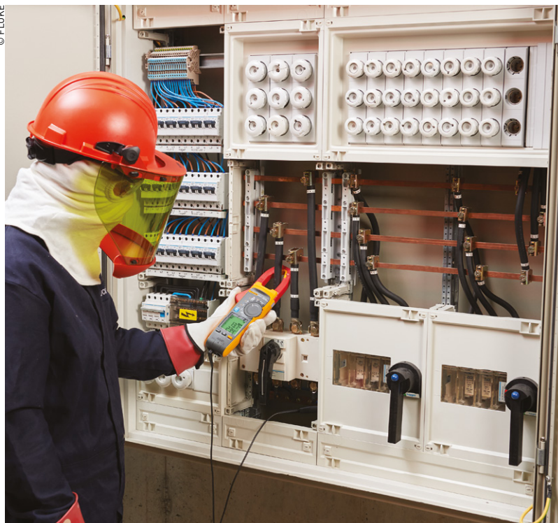
L'utilisation d'un multimètre « true-RMS » (valeur efficace vraie) et d'un oscilloscope portable permet de diagnostiquer les problèmes liés aux VFD.
