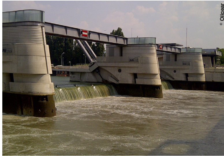
Une autre réalisation commune Oilgear/Douce Hydro : la motorisation hydraulique du barrage de Chatou (Yvelines).
