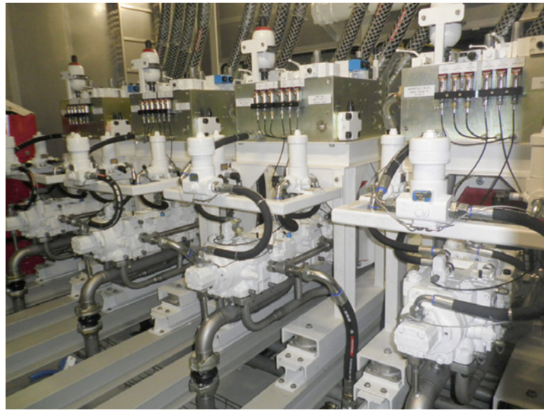
Groupes motopompes équipant une centrale hydraulique pour l'alimentation d'une tour de pose de flexibles sous la mer (VLS 6 Technip).
