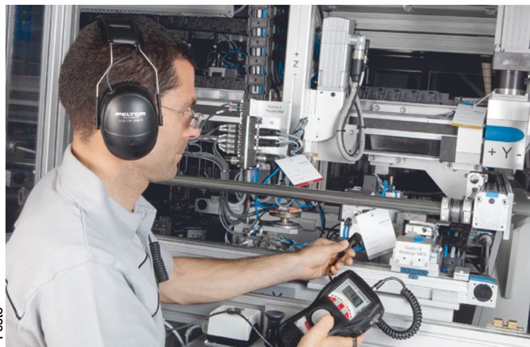
Le service d'économies d'énergie de Festo accompagne les clients pour la détection et la réparation des fuites d'air comprimé.
