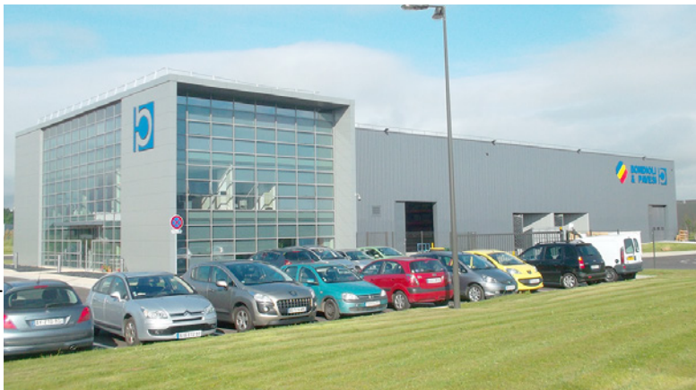
Le nouveau bâtiment de Bondioli & Pavesi est situé sur un terrain de 13.000 m 2 , rendant possible tout projet d'extension à l'avenir.
