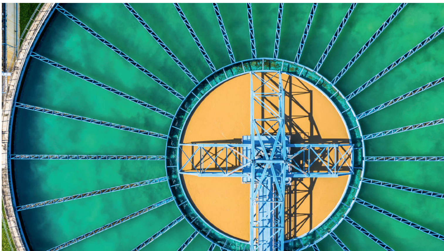
Les pompes de la station de traitement des eaux Ashford Common sont alimentées par des moteurs électriques WEG de 7,5 t. Chaque pompe est capable de pomper jusqu'à 180 000 m 3 par jour.
