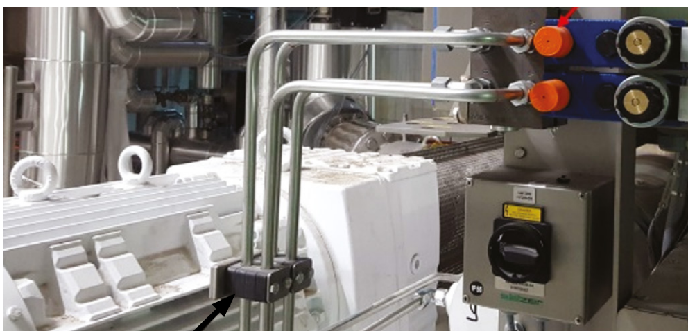
Tuyauteries rigides avec colliers de fixation.
