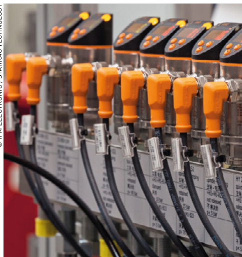
Les nombreux capteurs IO-Link sont paramétrables de manière centralisée.
