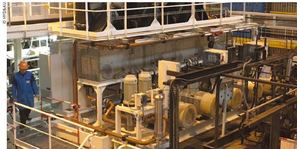
Exemple de réalisation faisant jouer les synergies au sein du groupe : groupe de génération de puissance avec réservoir de 5000 litres et puissance installée de 600 KW. Un vérin fourni par Hyd&Au Vérins avec bloc de distribution (diamètre 380x280, capacité 280 T). Armoire de puissance et de contrôle réalisée par Samelec.
