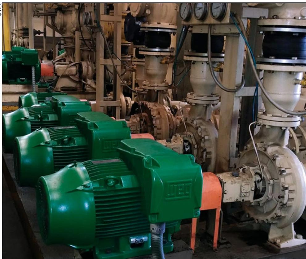
Cette solution d'efficacité énergétique WEG est utilisée dans divers secteurs d'activité, les économies d'énergie peuvent atteindre 70 %. Elle est composée d'un moteur W22 IR3 Premium et d'un variateur de vitesse CFW11. Il est également possible de réduire la consommation d'eau et de diminuer les coûts de maintenance et de fonctionnement des vannes de contrôle et de mieux contrôler le débit.
