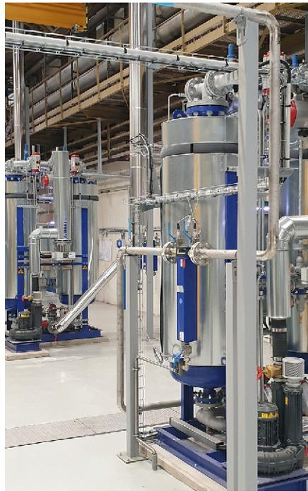
Le minéralier produit désormais un air comprimé de process sec à 40 bars en réduisant sa facture énergétique.
