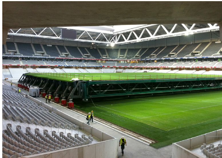
Le défi consistait à concevoir un système permettant d'assurer l'élévation et le déplacement d'un demi-terrain d'une longueur de 70 mètres sur une largeur de 55 mètres et d'un poids total de quelque 4.500 tonnes.
