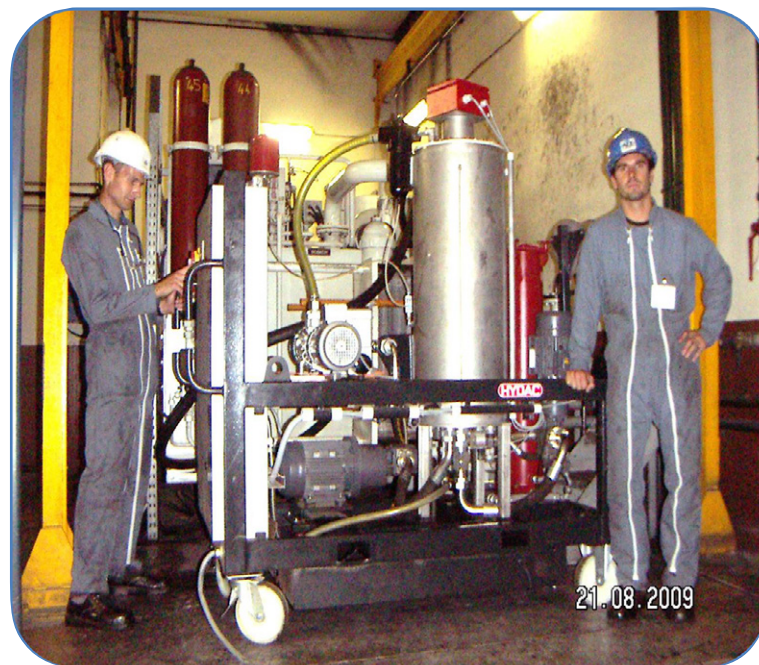
Intervention de techniciens ACE pour l'installation et la mise en route de matériels Hydac.
