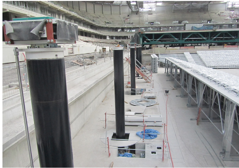
Plutôt que de centraliser la génération hydraulique en un seul lieu, il a été préconisé de doter d'une centrale hydraulique indépendante chacun des 12 vérins de levage fournis par Douce Hydro. © ELISA - Valode et Pistre Architectes - Atelier Ferret Architecture - EIFFAGE TP - Oilgear Towler
