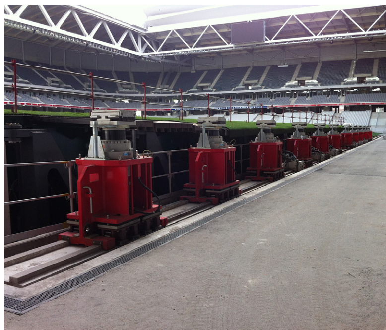
Un système mobile réalisé par NFM, en l'occurrence des chariots coulissant sur des rails à l'aide de galets, est utilisé pour la translation.
