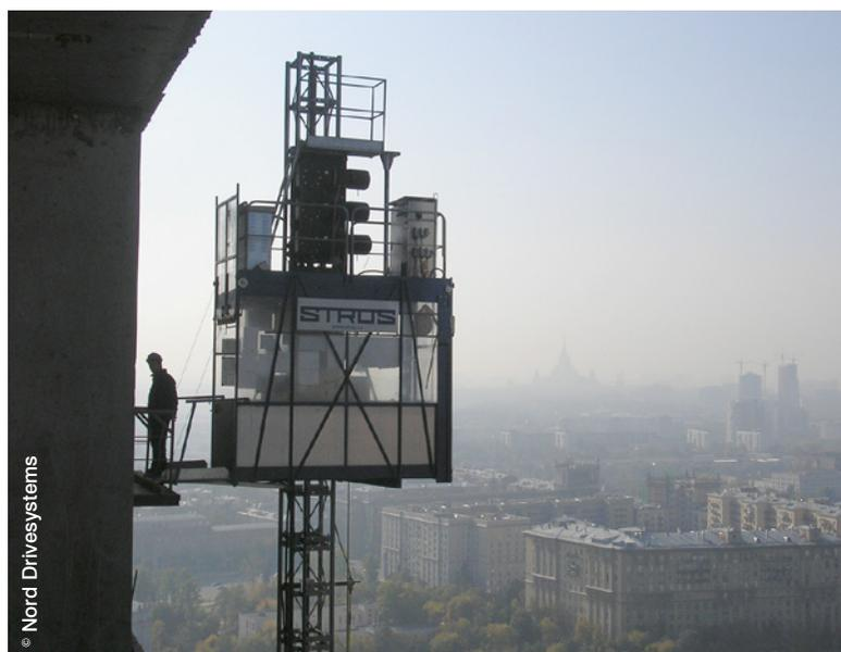
Le monte-charge NOV 2032 employé à Moscou a une capacité de charge de 2 tonnes. Il est actionné par trois motoréducteurs et un variateur en armoire Nord.
