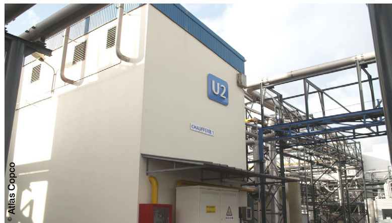
La salle de compresseurs est située à proximité immédiate de la chaufferie de l'usine car l'installation a été conçue de manière à récupérer la chaleur « produite » par les compresseurs afin de réchauffer l'eau.
