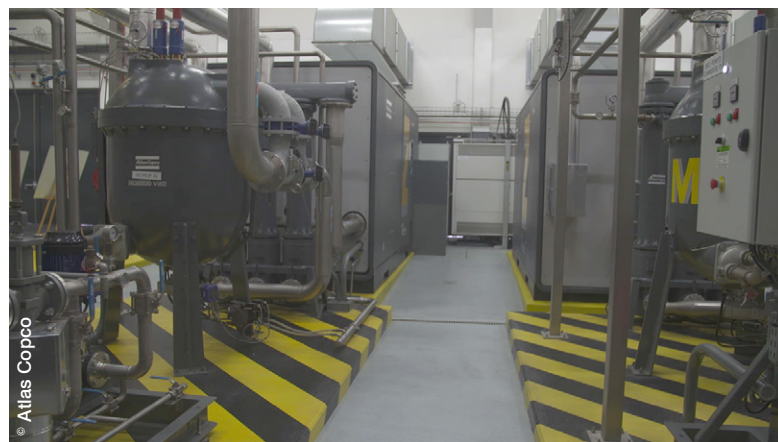
Les compresseurs sont couplés à des sécheurs à adsorption et régénération par chaleur de compression type MD 2500 VSD.
