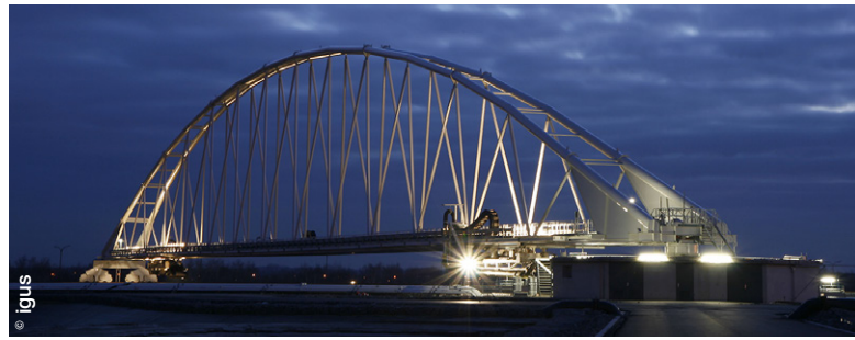
Cette installation de traitement des boues dans le port d'Anvers fait appel à la plus grande chaîne porte-câbles en polymères du monde, la E4.350. Ce projet a remporté le vector d'argent en 2012.
