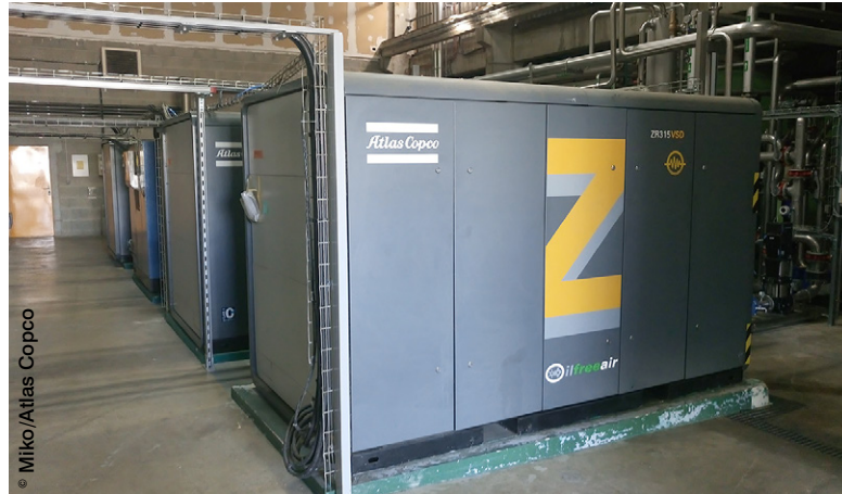
Atlas Copco a préconisé l'utilisation de la vitesse variable, une technologie dont le groupe suédois a été précurseur il y a plus de vingt ans.
