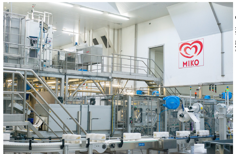
L'air comprimé est partout sur le site de Saint-Dizier, tant pour faire fonctionner les vérins pneumatiques que pour intervenir directement dans le process de fabrication.
