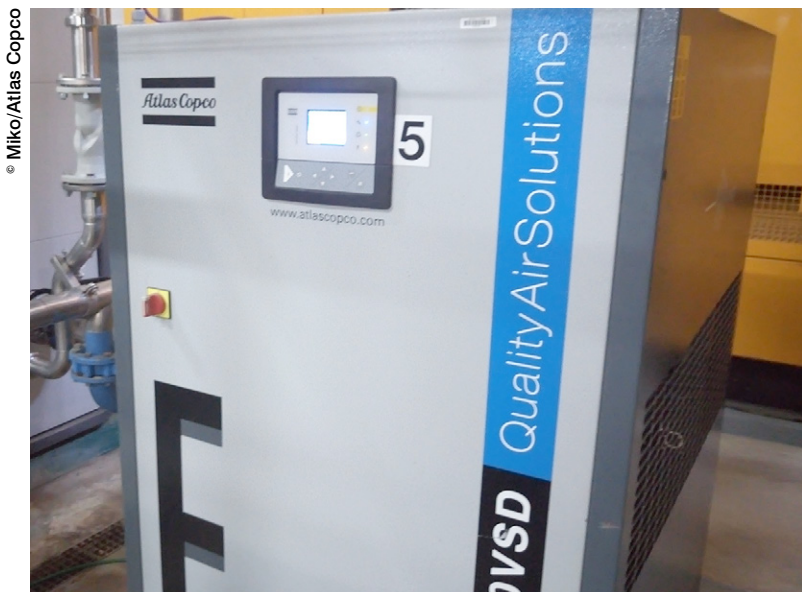
Atlas Copco a fourni deux sécheurs par réfrigération de type FD 870 d'une capacité de traitement de 3.100 m 3 /heure.
