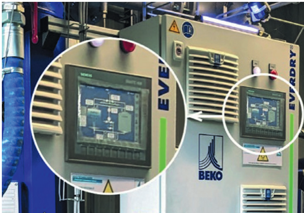
Le système de surveillance compact, installé après le dernier filtre, mesure en continu la teneur résiduelle en hydrocarbures de l'air comprimé, pour une sécurité accrue des processus.
