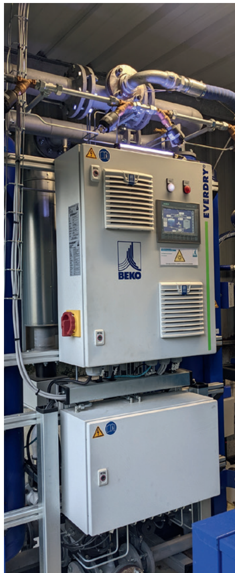
La solution complète a permis au client d'obtenir un air comprimé de la classe voulue : [1:2:1].
