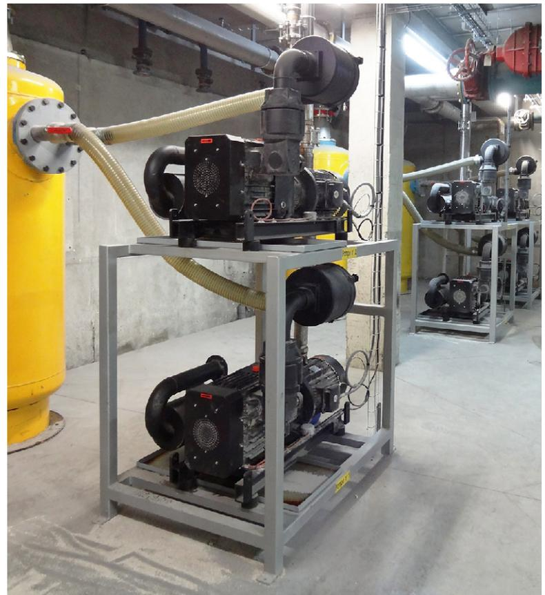
Le principe des rotors à lobes permet aux pompes Mink de compresser sans lubrification et sans contact, donc sans frottement et sans usure des pièces.
