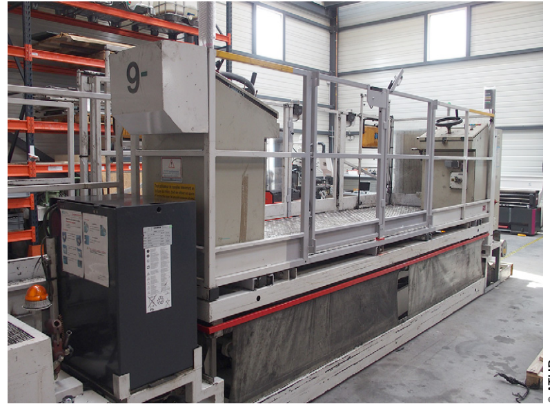
Modification des équipements électro-mécaniques et boucle de sécurité sur une nacelle.
